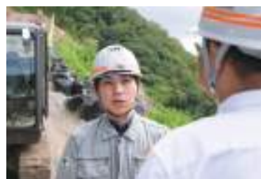
建設現場ではICT機器の導入が進んでおり、安全性や生産性なども著しく向上している。知識や技術を持つ若手社員への期待は大きい
