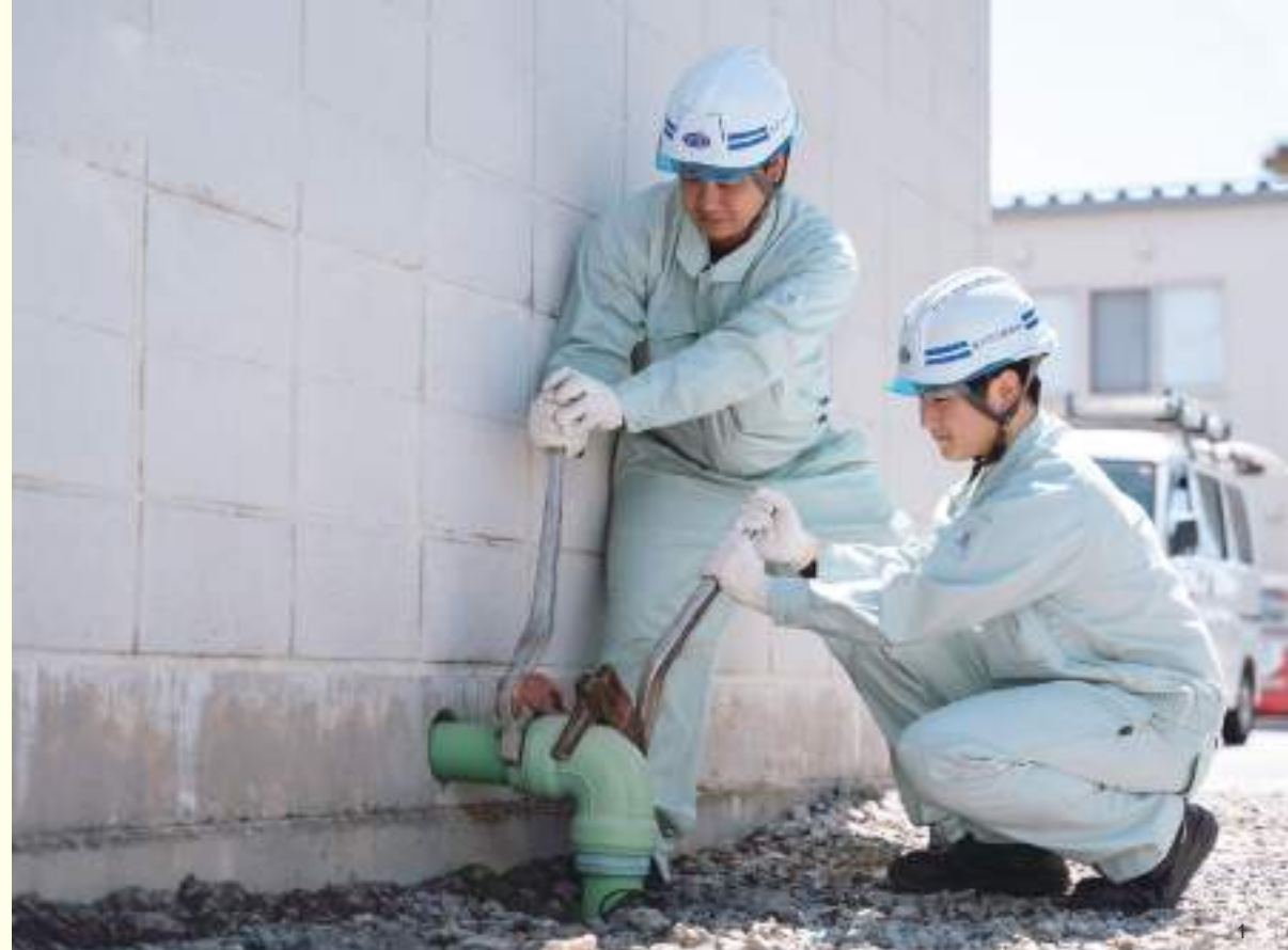
1 ガスや電気などを安全・確実に供給するには、配管が適切な状態で保たれている必要がある。新設時はもちろん、施工後も定期的な確認や補修などが欠かせない 2 3 事業内容は7部門に及び、他部門スタッフとの連携も密にしている 4 現場での技術経験もある豊嶋社長。「仕事が形として残り、やりがいを実感できるのが魅力です」
