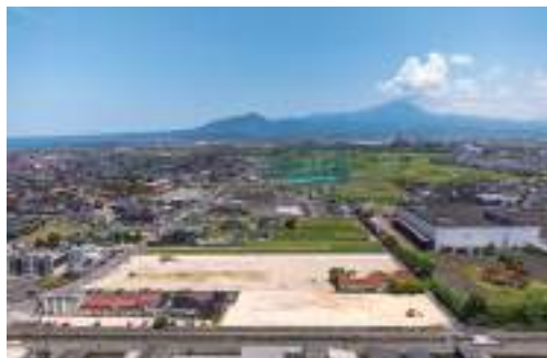
造成工事が完了した米子市上福原の新社屋建設予定地。CLT工法を使用した木造本社棟(4階建)、倉庫・加工棟、会議・研修棟から成る
